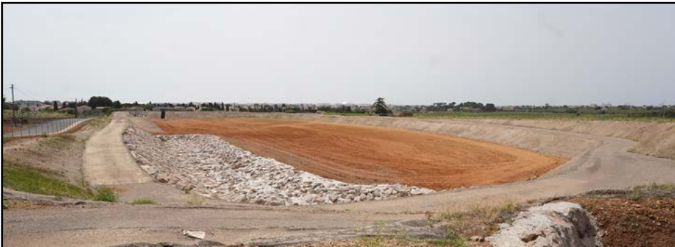
Fin mai : Bassin de rétention achevé pour sécuriser les habitations et protéger l'environnement
