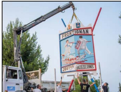
29 juin : Réinstallation du pavois géant en entrée de ville
