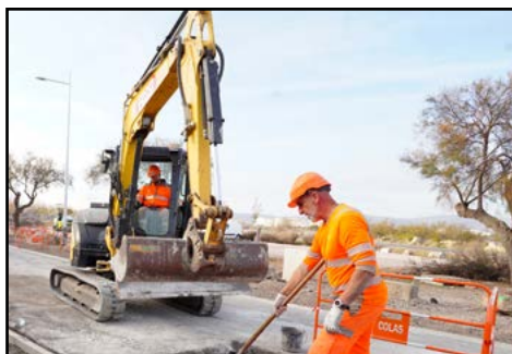
Décembre : Début des travaux de l'avenue Vauban - 780 000€ d'investissement
