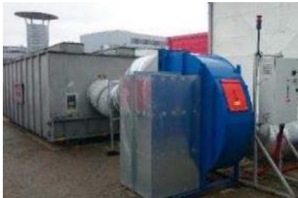
Extracteur et insufflateur d'air des tentes en caissons insonorisés
