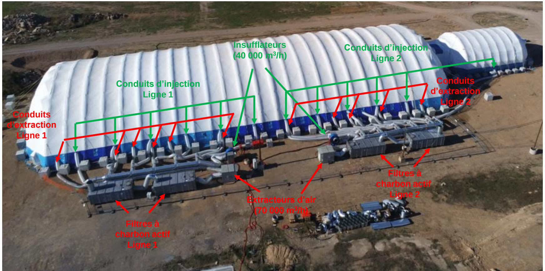
Unité de traitement de l'air de la tente gonflable utilisée pendant le test pilote
