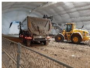
Chargement des camions sous tente
