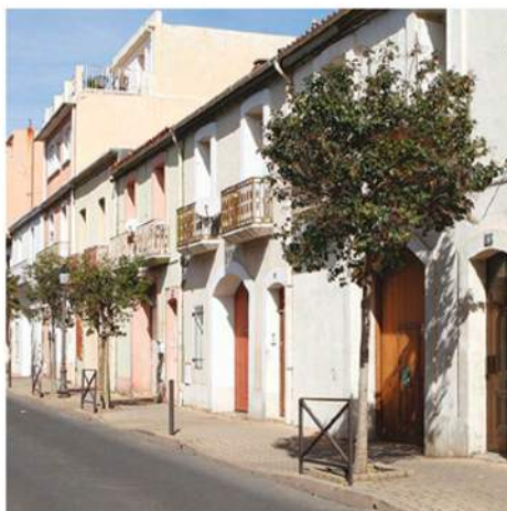
Lotissement fin XIXe constitué de maisons vigneronnes en alignement.
