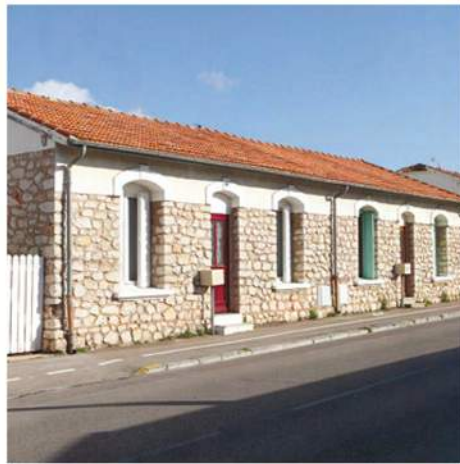
Ensemble de maisons mitoyennes en bande (Habitations à bon marché, 1920).
