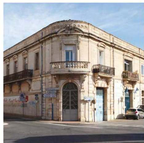
Immeuble du XIXe en pierre de taille calcaire, la teinte «sable» domine.
