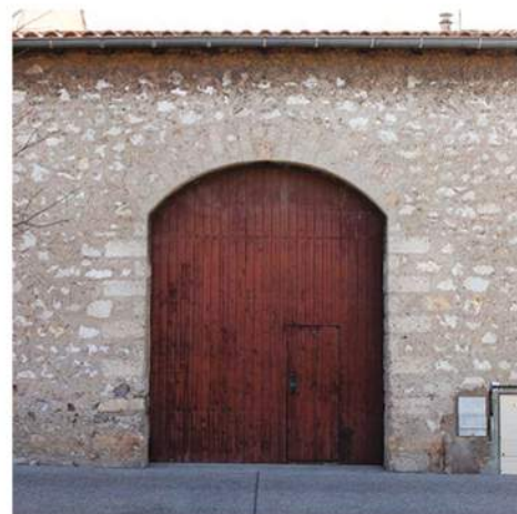
Remise agricole en maellons calcaires et porte ocre-rouge (fin XIXe-début XXe s.).
