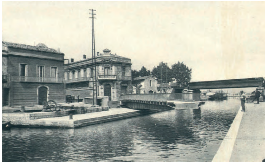
Pont du chemin de fer sous lequel où nous pêchions au « saousset »
