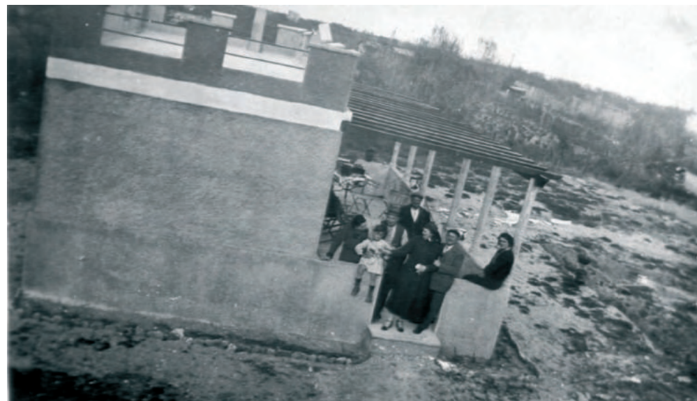
La maison de la plage en construction
