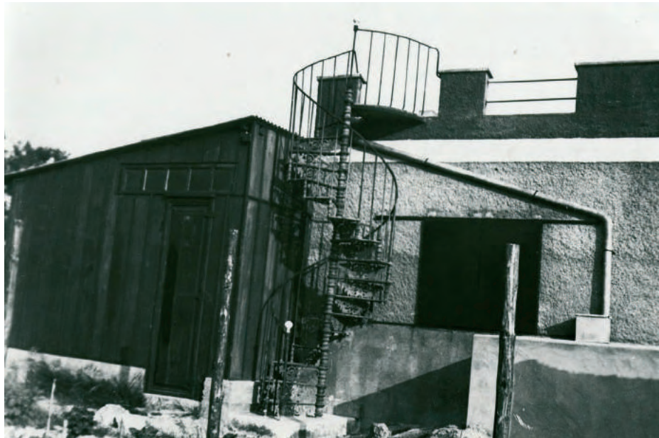
La citerne à eau et l'escalier pour accéder à la chambre du 1er étage
