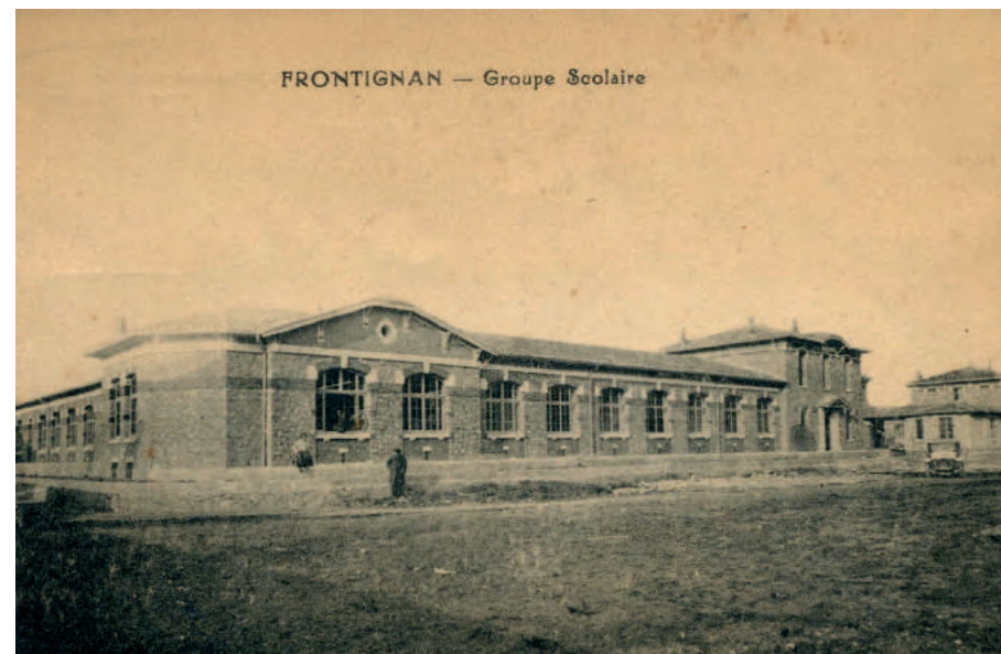
L'école Anatole-France en construction en 1925
