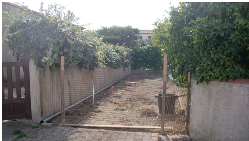
Source : impasse des Palmiers, photo prise par la police municipale en octobre 2019 à la demande du commissaire enquêteur.
