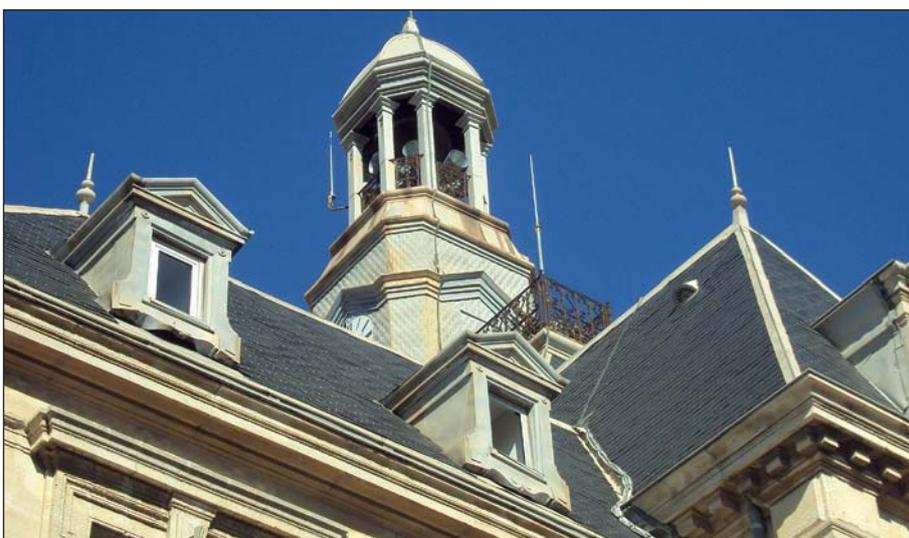
*Vue des toits mansardés et ardoisés, des lucarnes du 3<sup>e</sup> étage et du campanile. Cette tourelle ajourée est le dernier niveau accessible par un escalier intérieur.*
