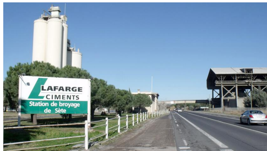
Site des anciennes usines Lafarge en bordure de l’étang de Thau. Source : ADELE-SFI
