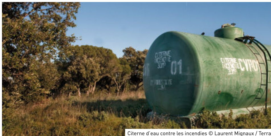
Citerne d'eau contre les incendies © Laurent Mignaux / Terra
