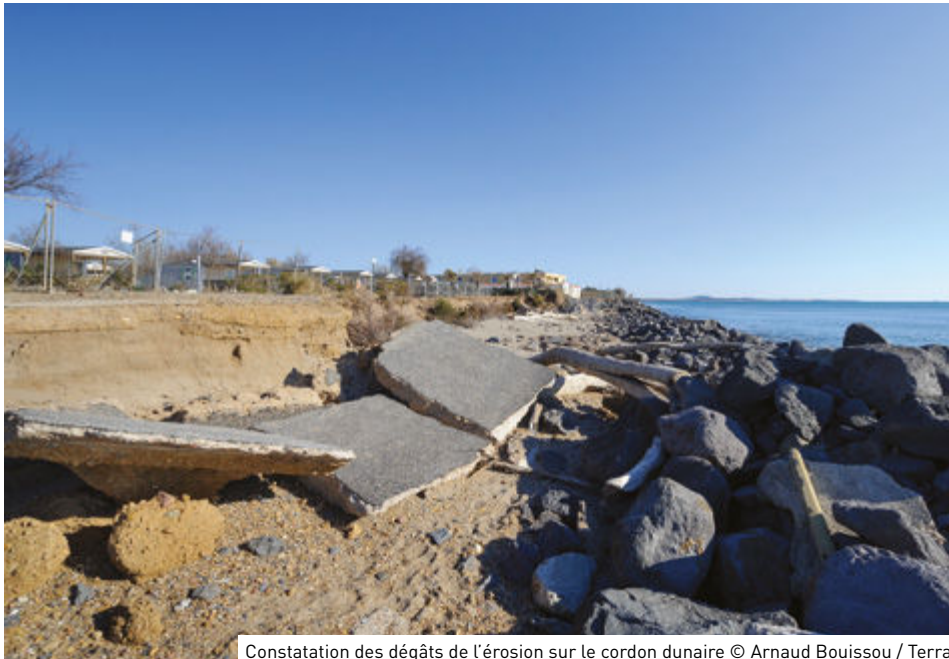
Constatation des dégâts de l'érosion sur le cordon dunaire © Arnaud Bouissou / Terra
