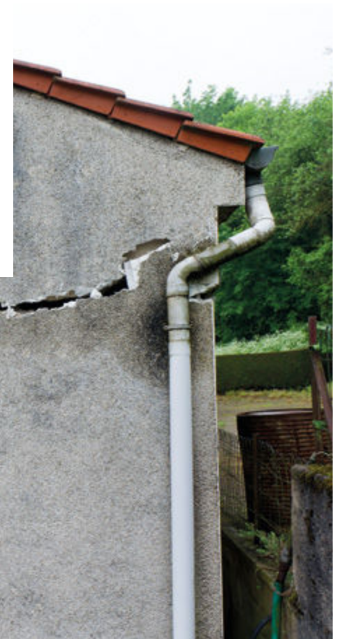
Fissures sur un mur en pierre © Laurent Mignaux / Terra
