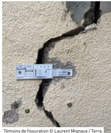
Témoins de fissuration © Laurent Mignaux / Terra
