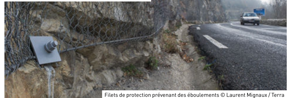
Filets de protection prévenant des éboulements © Laurent Mignaux / Terra
