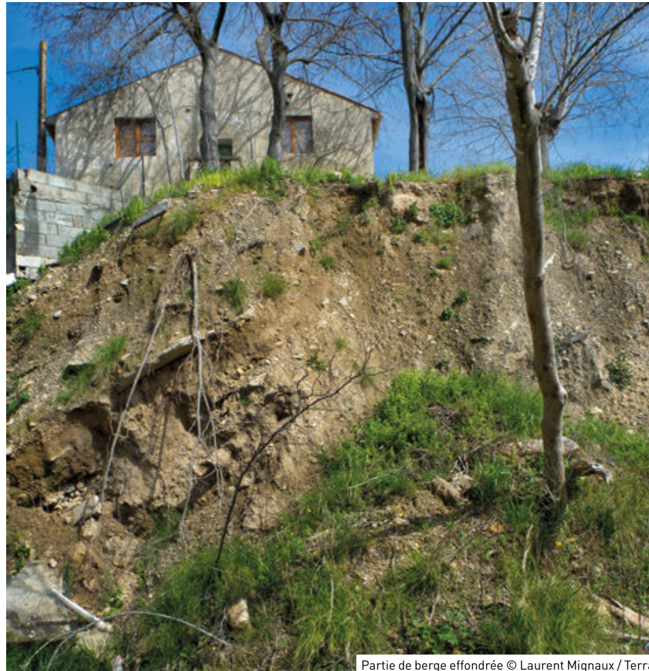
Partie de berge effondrée © Laurent Mignaux / Terra
