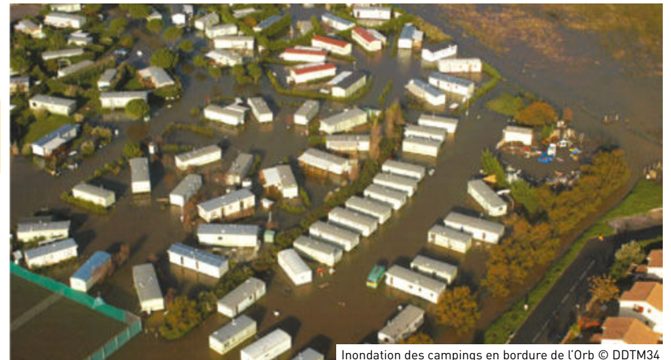
Inondation des campings en bordure de l'Orb © DDTM34
