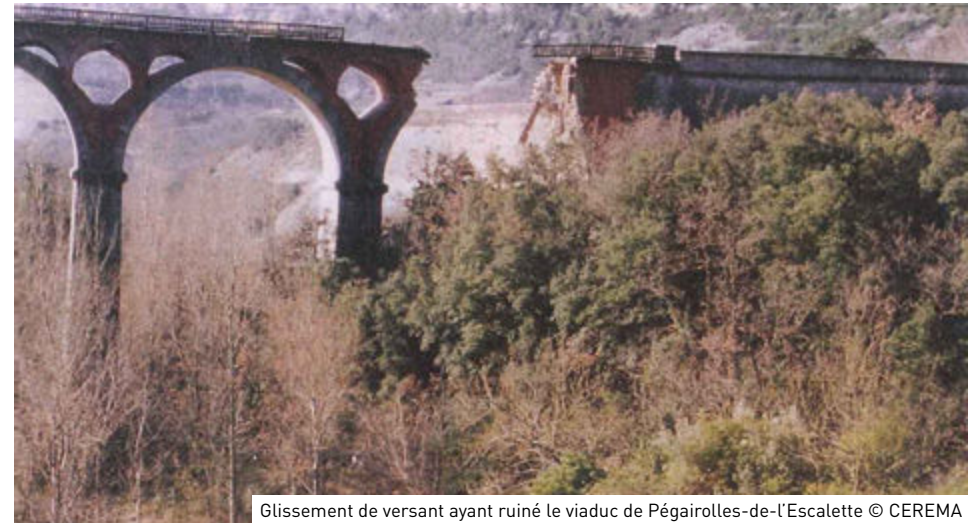
Glissement de versant ayant ruiné le viaduc de Pégairolles-de-l'Escalette © CEREMA
