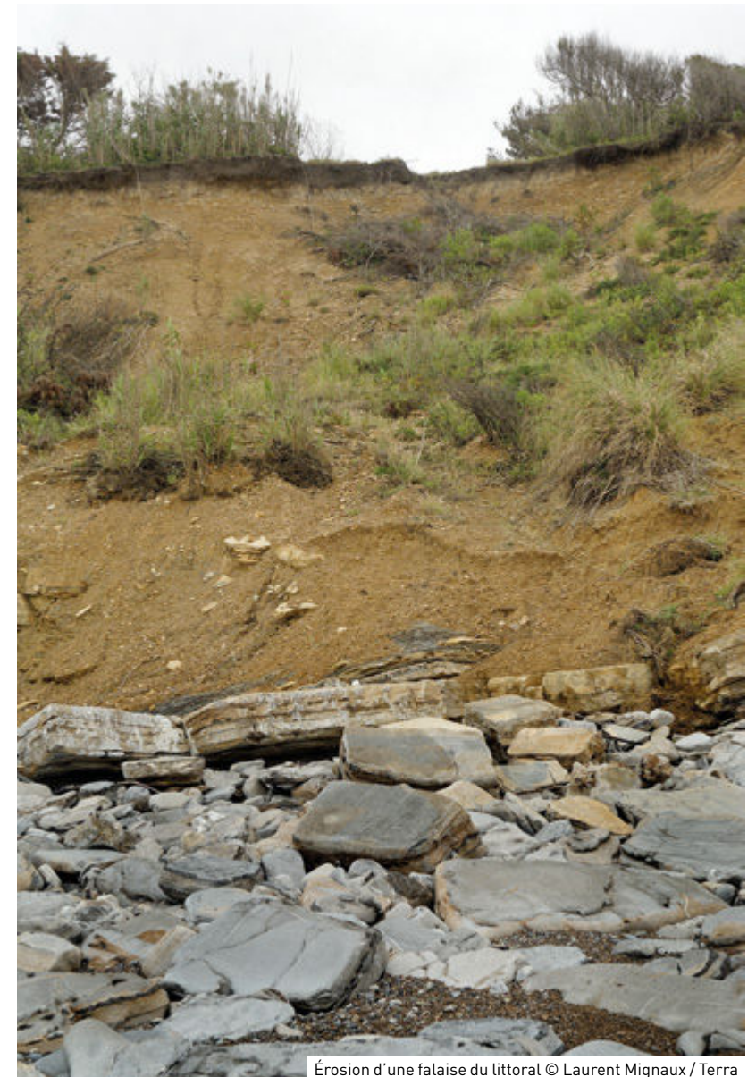
Érosion d'une falaise du littoral © Laurent Mignaux / Terra
