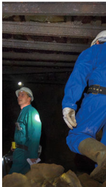
Surveillance des cavités © Laurent Mignaux / Terra
