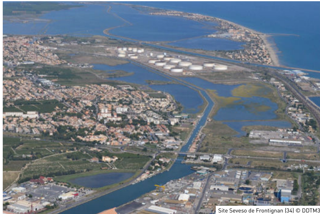
Site Seveso de Frontignan (34) © DDTM34
