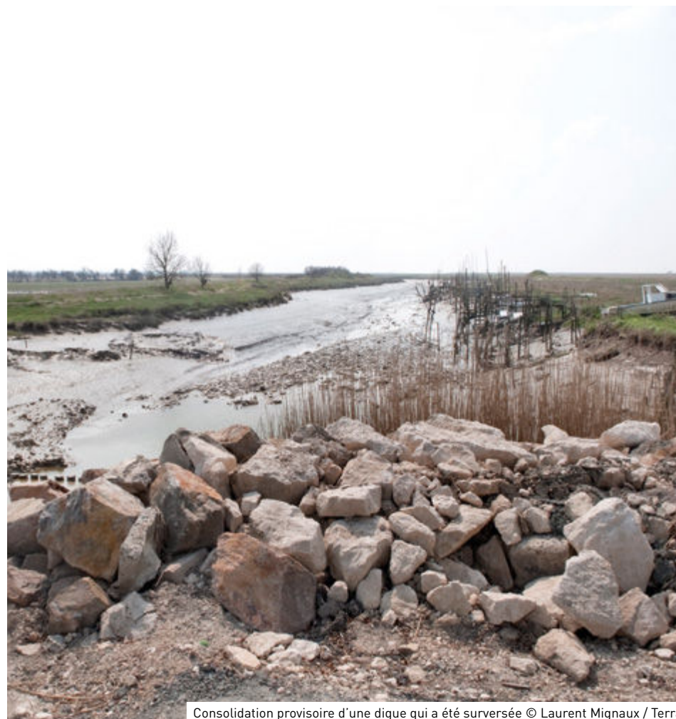
Consolidation provisoire d'une digue qui a été surversée © Laurent Mignaux / Terra
