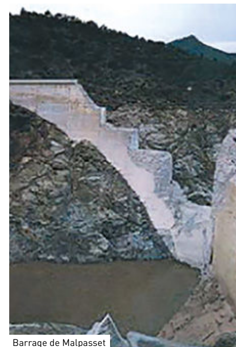
Barrage de Malpasset
